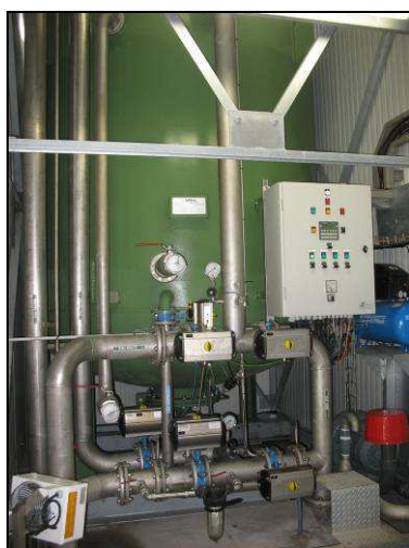
VUE INTERIEURE STATION DE TRAITEMENT PAR CHARBON ACTIF
